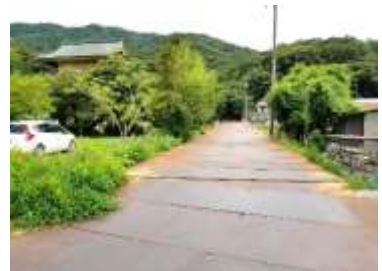
拡張工事された山門脇の道路
