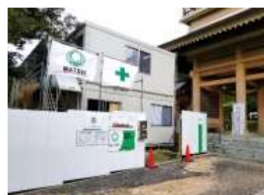
山門前の工事管理棟
