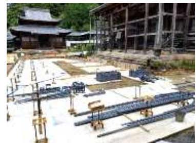
御影堂覆屋の基礎工事
