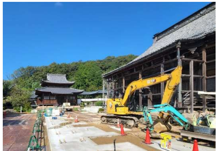
御影堂覆屋の基礎工事状況
